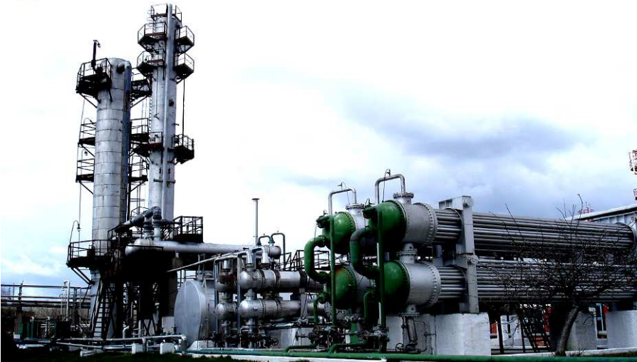
Рисунок 45 - Установа осушення природного газу Гнідинцівського ГПЗ (ВАТ «Укрнафта»)
