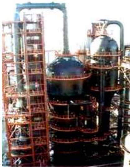
Рисунок 31 - Реакційний блок УКК Лисичанського НПЗ («ТНК-ВР»)
